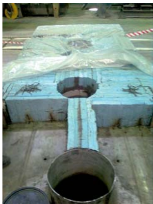
Рис. 3. Рабочий этап монтажа футеровки на крышке стэнда разогрева промковшей (конверторный цех НТМК)
