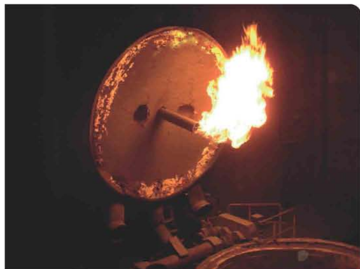
Фото 4. Крышка стэнда разогрева сталеразливочных ковшей в работе (МЕЧЕЛ, Челябинский металлургический комбинат, ЭСПЦ-6) Mechel ChMK Vtu' cover.
